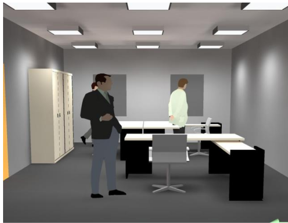
Abb. 12b Deckenaufbauleuchten mit Spiegelraster haben keine große Leuchtfläche. Beim optimalen Beleuchtungswinkel von 65° verdecken sie die Leuchtmittel
